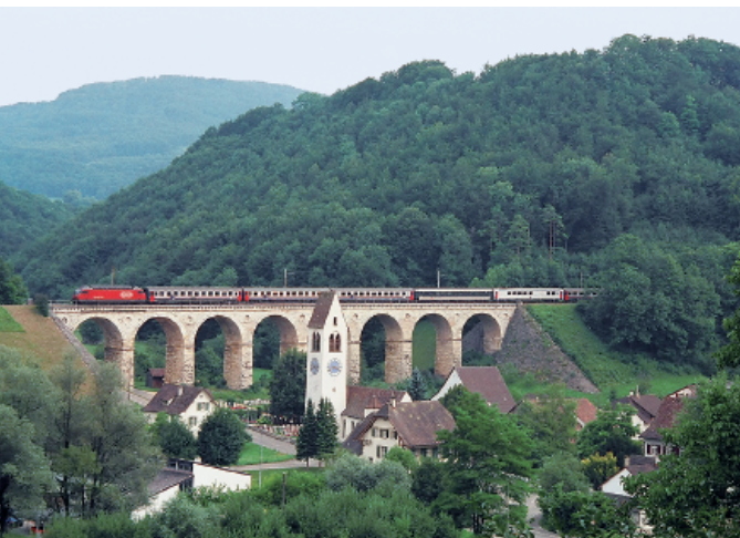
Die Bahnlinie Sissach-Läufelfingen ist reich an Viadukten.
