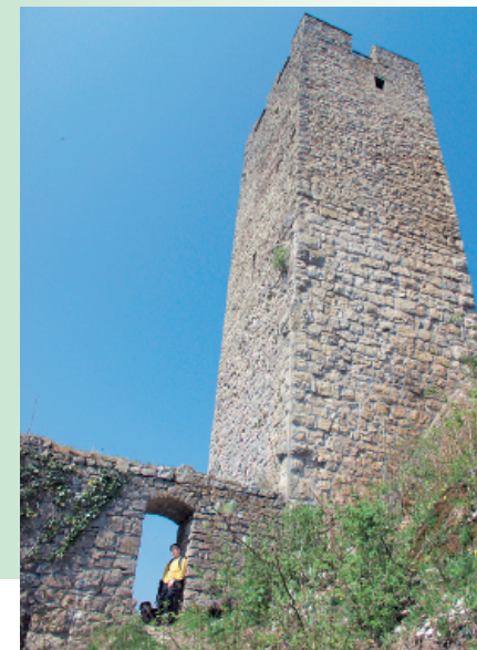
Der praktisch intakte Bergfried überragt die fast vollständig zerstörte Burg.
