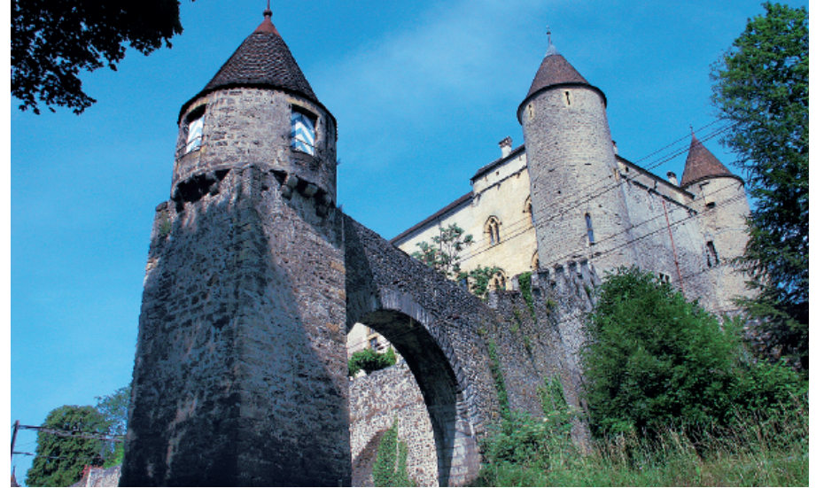
Der Bau der Burg Grandson ist vermutlich auf Otto I. (1240–1328) zurückzuführen.
