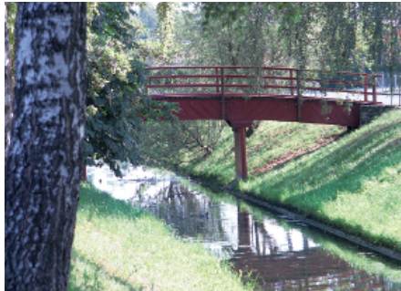
Zahlreiche Kanäle und Brücken am idyllischen Weg von Grandson nach Yverdon.
